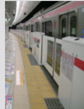
ホームドア設置 Installation of platform doors
