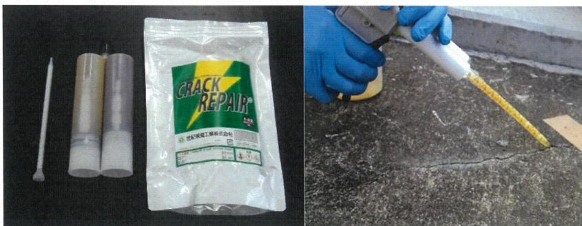
CRACK REPAIR 製品一式 ノズル付スタティックミキサーを使った施工状況
