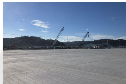
宮古港舗装復旧工事
