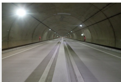
檜這トンネル舗装工事
