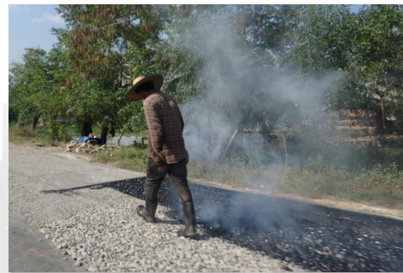
ミャンマーでの施工状況
