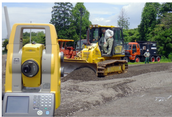
ICT施工状況
