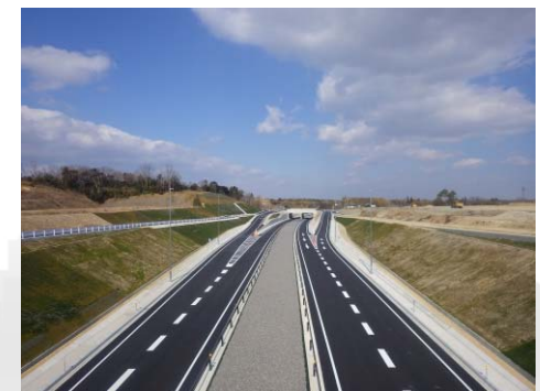
三行北舗装工事
