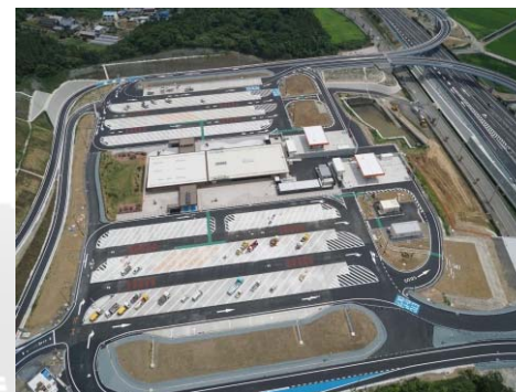
太田パーキングエリア舗装工事
