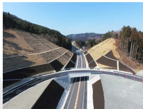
唐桑南地区舗装工事
