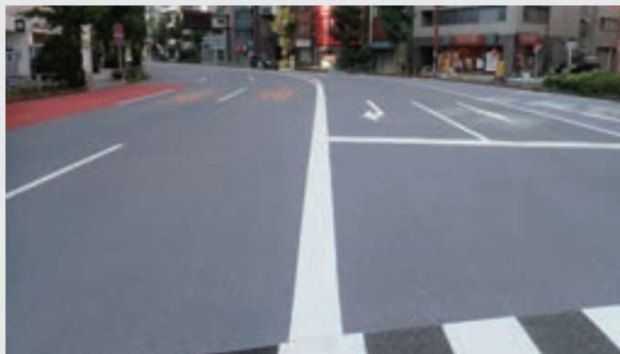
H30 日本橋室町地区舗装繕繕工事 工事場所：東京都
