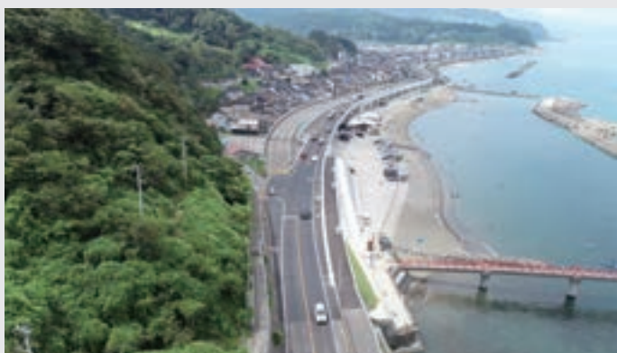
弁天大橋架替舗装工事 工事場所：新潟県
