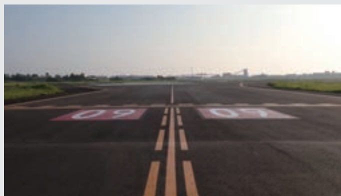
平成30年度宮崎空港誘導路(S1・S2)改良外1件工事 工事場所：宮崎県
