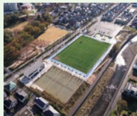
鶴間公園整備工事(その2) 工事場所:東京都
