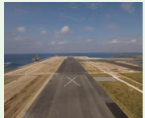
那覇空港滑走路増設4工区舗装等工事 工事場所：沖縄県
