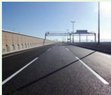
舗装補修大規模修繕工事(30-6-湾) 工事場所：大阪府
