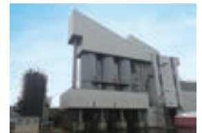
奈良合材工場(奈良県)
