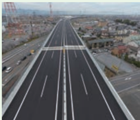
東海環状自動車道大野・神戸IC~大垣西IC間舗装工事 工事場所：岐阜県
