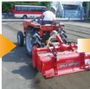
② 敷均し～2次混合
