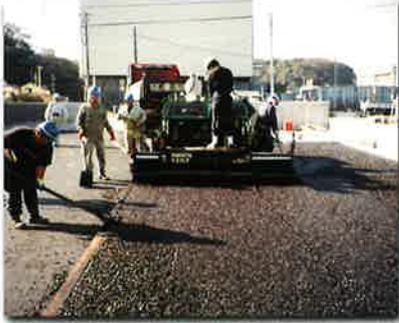
開粒度アスファルト混合物を舗設します。
