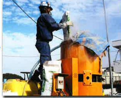
現地で混合機を使って保水性セメントミルクを製造します。
