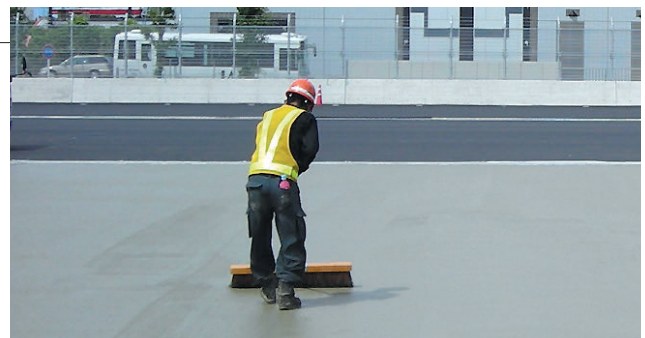
写真-2 仕上げ状況
