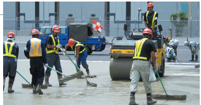
写真-1 セメントミルク注入及び浸透状況
