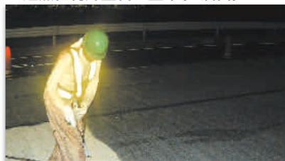
1層目が乾燥した後(約15~30分)同様の手順で2層目を塗布します。
