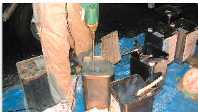
顔料の入ったA液と硬化剤の入ったB液の2液を攪拌します。
