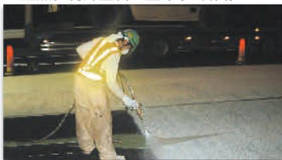
特殊散布機を使って舗装面に遮熱性塗料を塗布します。
