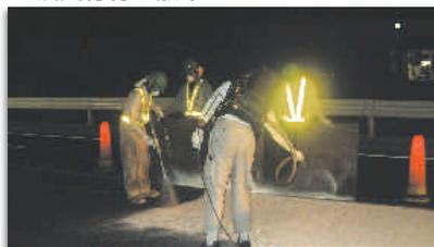
1層目の塗布直後に硬質骨材を均等に散布し、塗料に定着させます。
